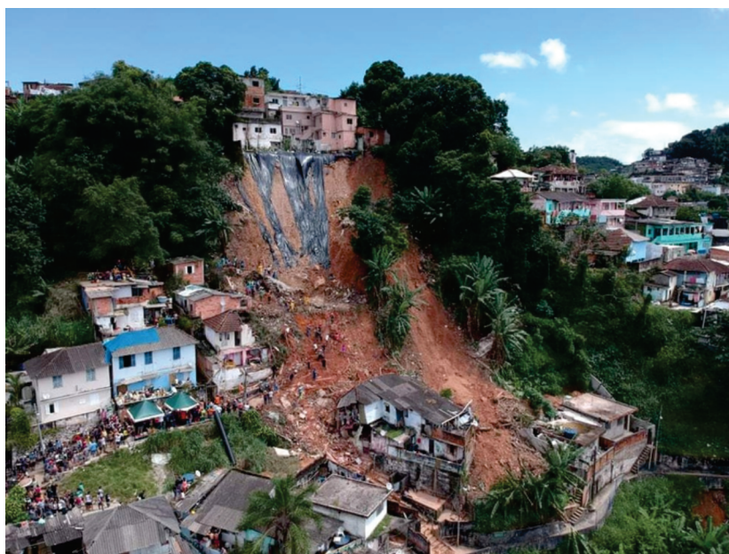
Figura 15. Imagem ilustrativa de deslizamento de encosta.
